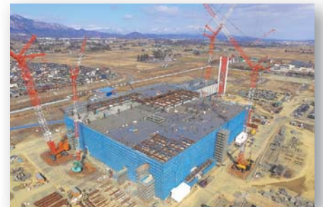
矢巾新附属病院建築状況
