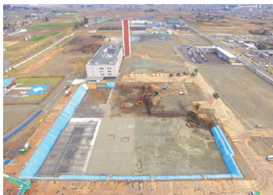
平成29年4月状況
