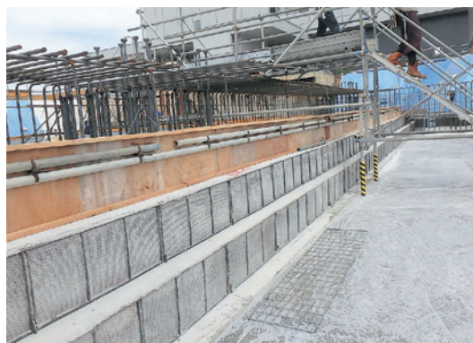
基礎コンクリート打ち継ぎ
