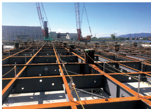
鉄骨建方工事
