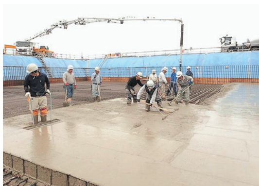
基礎コンクリート打設状況
