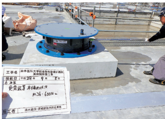
免震装置設置
