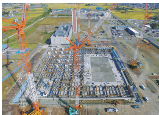
平成29年10月状況
