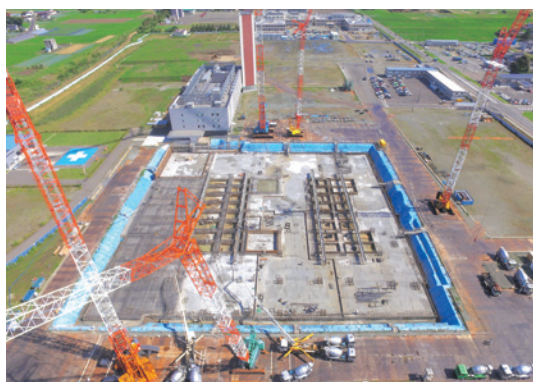
平成29年7月状況
