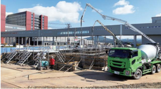
令和2年10月13日 基礎コンクリート打設
