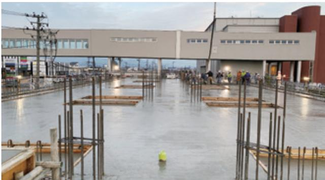
令和2年11月19日 2階床コンクリート打設
