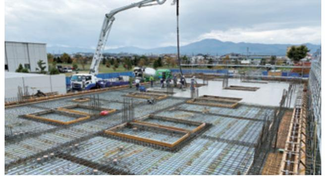
令和2年10月30日 1階床コンクリート打設
