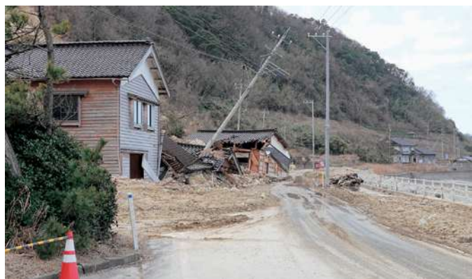
本来の車道は崖崩れや家屋の倒壊により走行することができない（発災から約1ヶ月後の様子）
