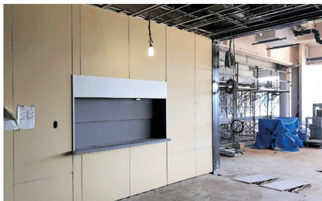
1階防災センターの内装
