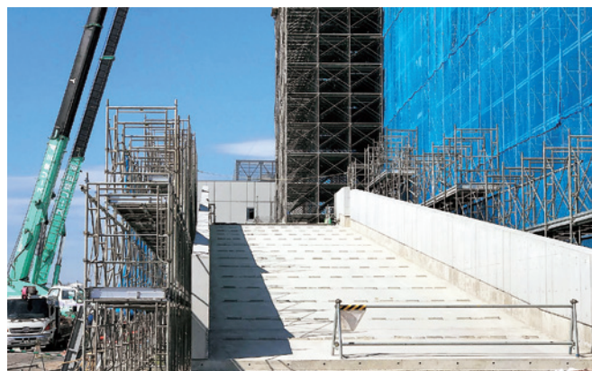
2階サービスヤード等へ続くスロープ
