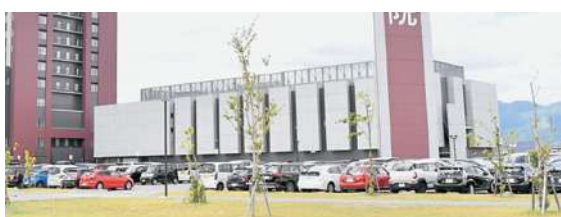
エネルギーセンター
