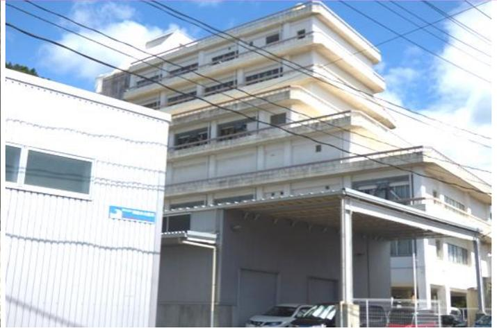
釜石駅から市内側に1km弱歩いたところにある釜石のぞみ病院。津波の被害を受け、1階部分が浸水。非常用発電機が使用不可能となり病院機能が停止し、最終的に病院避難を選択した病院である。上の写真2枚にある横長の青いパネルが津波の浸水高を示しており、1階天井近くまで浸水したことが判る。
