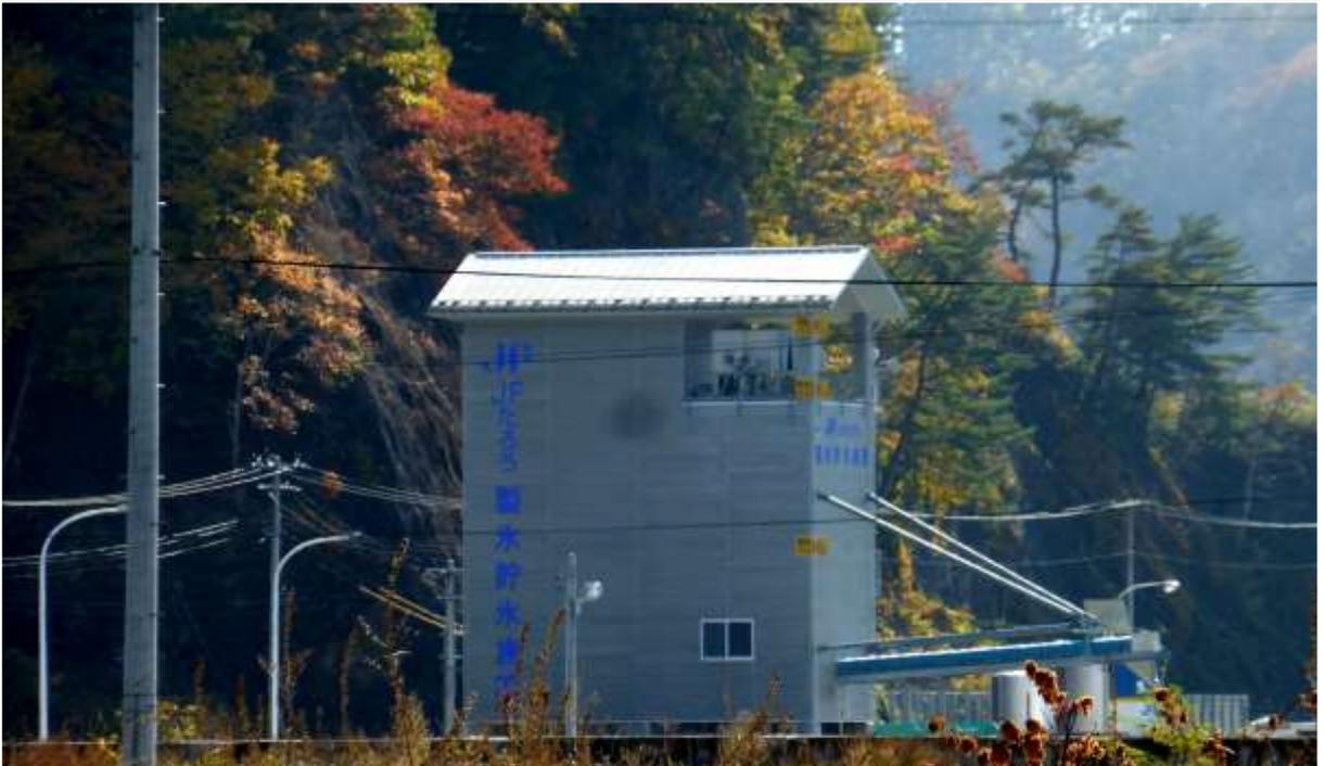
港の北岸に再建された漁協の製氷貯氷施設。黄色い目印は過去に田老地区を襲った津波の高さを示しています。上から東日本大震災、明治三陸津波、昭和三陸津波です。今回の津波は波高が約15mであったといわれています。下の写真は、津波被害を免れた山側の住宅地です。市街地は防潮堤で囲われていたため、海面を視認することができませんでした。対策として旧役場施設に海を監視するカメラを設置し、常時監視をしていましたが、地震による停電により、カメラ設備と放送施設が使用不能になってしまい、その機能を活かすことができませんでした。
