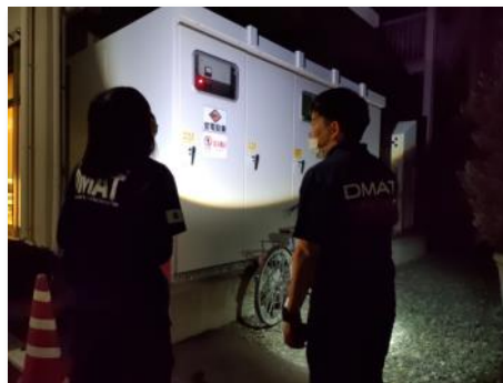
夜間の余震の影響がないか、停電中の施設の安全確認のため巡回した
