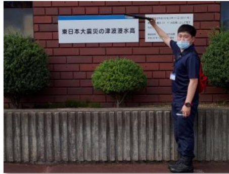
東日本大震災時には、津波によりこの高さまで浸水した
